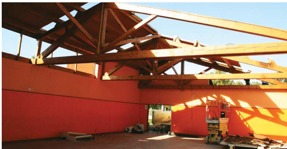
Début des travaux de rénovation
