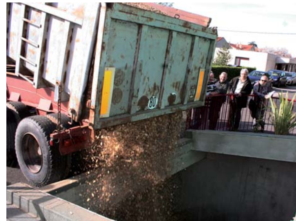
Déchargement du bois à la chaufferie de l'école Joliot Curie
